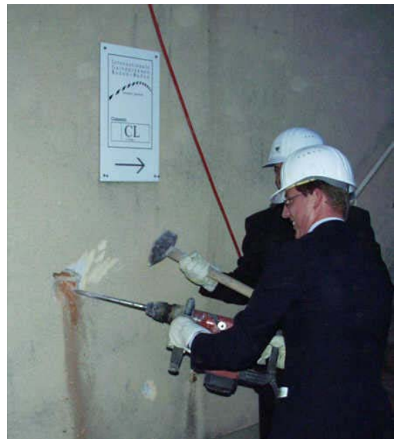
Symbolischer Beginn der Abrissarbeiten
