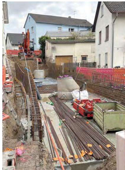
In der Gärtnerstraße gehen die Arbeiten an der Rampe weiter gut voran. Aktuell wird abschnittsweise die Bodenplatte betoniert, parallel dazu wird in den bereits betonierten Abschnitten die Bewehrung für die Wände gebunden.
