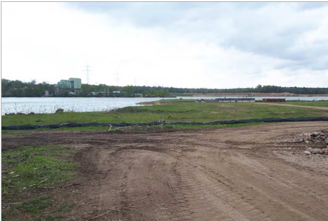
Abb. 15: Geplante Lager- und Montagefläche für die PV-Anlage (24.04.23)
