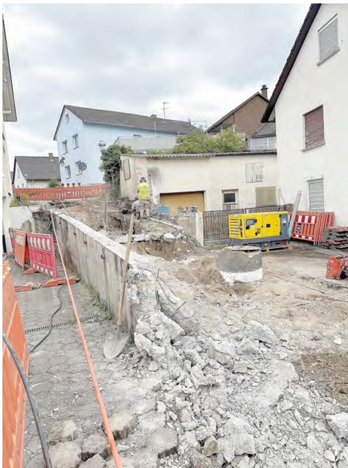
Nachdem der Rückbau der bestehenden Rampe abgeschlossen ist, wird in diesem Bereich der Abwasserkanal erneuert, sodass dann ab September/Oktober die Hochbauarbeiten für die neue Rampe durchgeführt werden können.
