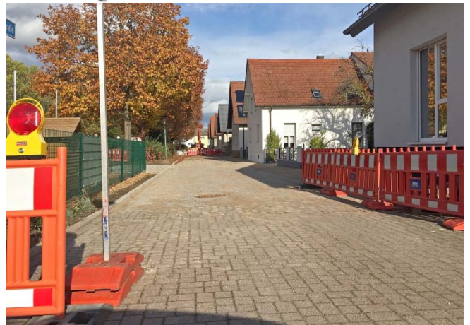
Ein Teilabschnitt wurde bereits fertiggestellt
