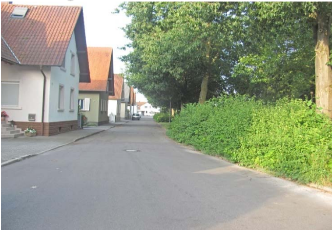
Zustand der Friedrichstraße vor Baubeginn
