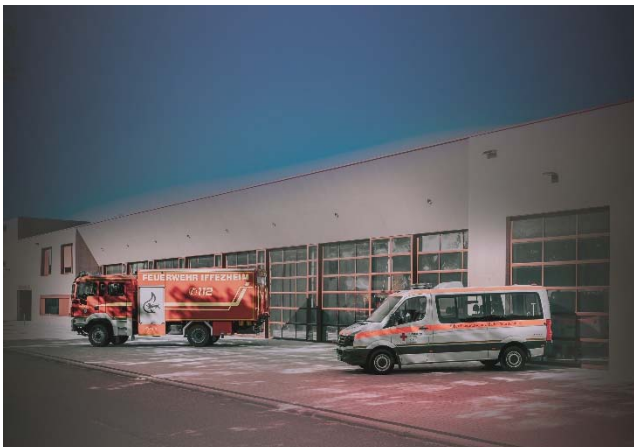
Das neue Feuerwehrhaus mit DRK-Depot in der Hügelsheimer Straße 31
