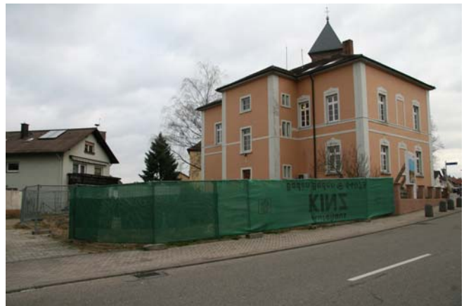
Rathaus aus westlicher Ansicht
