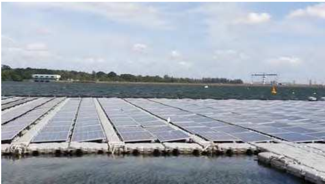
Abbildung 6.7: Schwimmende Photovoltaik-Anlage auf dem Tengeh Reservoir in Singapur (Bild: Yang et al. 2022)
